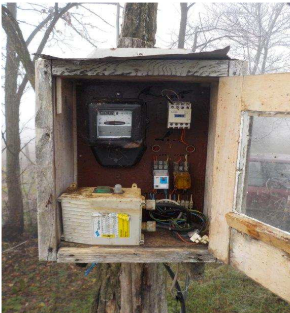
Slika 6: Oblik neovlašćenog korišćenja električne energije kod korisnika broj 2 (korišćenje električne energije preko mernog uređaja na kome je onemogućeno pravilno registrovanje električne energije).
