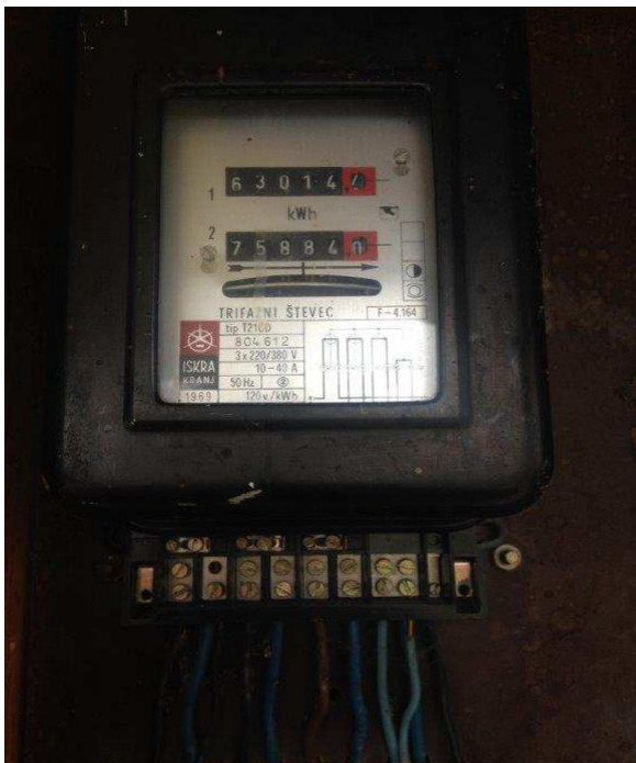
Slika 5: Oblik neovlašćenog korišćenja električne energije kod korisnika broj 1 (razmaknut naponski merni most)
